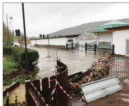
L'allagamento della zona Lido da parte del rio Giare
